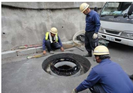
④受枠設置
