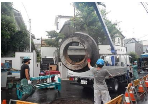
②舗装盤撤去
